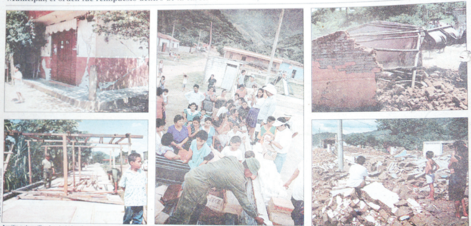
Auxilio a damnificados, trabajos de reconstrucción, demoliciones y otros aspectos de los daños provocados por el sismo del pasado viernes 20, en Villaflores. (Pág. 10 y 18)
