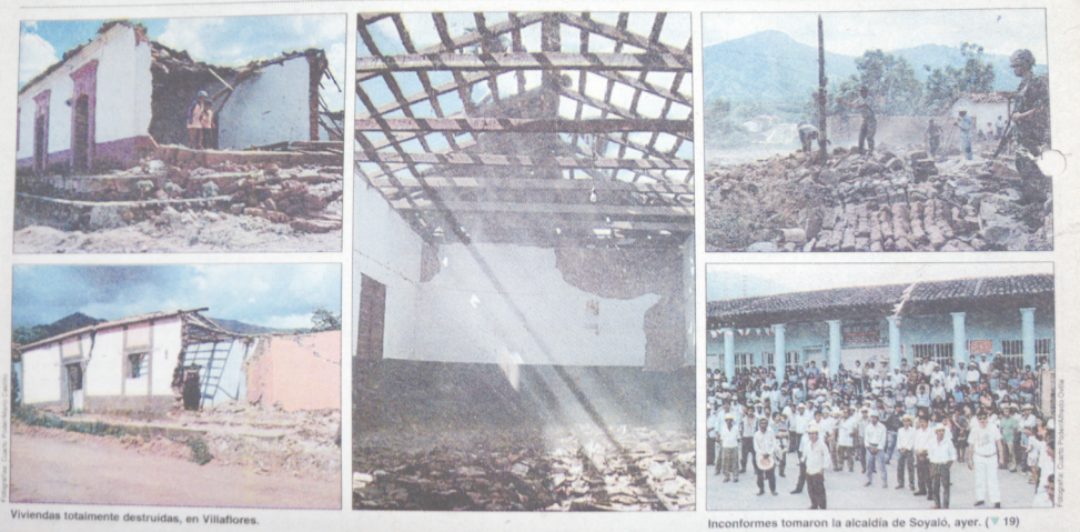
Viviendas totalmente destruidas, en Villaflores.
